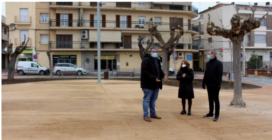
Alfonso Adán y José Miguel Burillo inspeccionando las obras con la aparejadora municipal, Lourdes Lloret.
